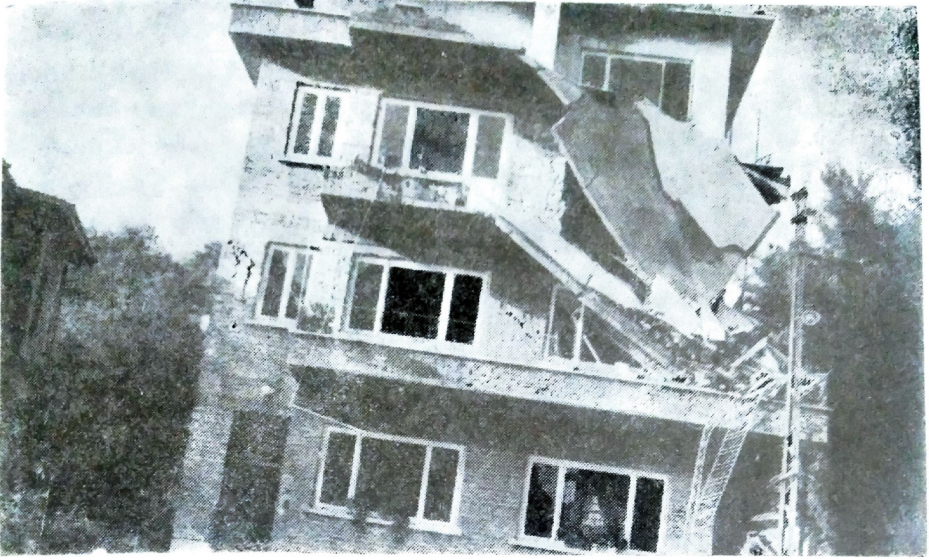
Foto 3 - Bartın'da Orduyeri mahallesinde, yalnız balkonu yıkılmış ev.
